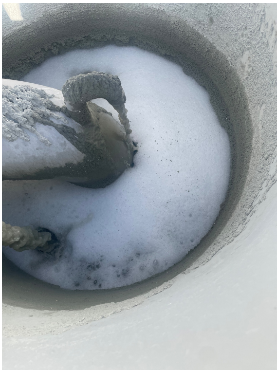
Schiuma persistente nel bacino / pozzetto di processo.
